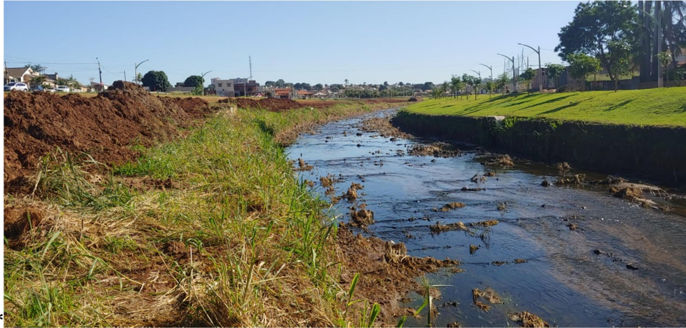
Figura 1.2 – Deposição de sedimentos no trecho canalizado do Córrego do Sapo.
