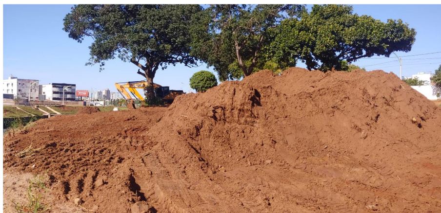
Figura 1.4 – Processo de dragagem no Córrego do Sapo.
